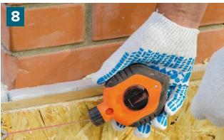
Отметьте точку на высоту одной плитки от уровня отмостки и отмерьте расстояние от верхней части цоколя до этой точки. Отмерьте это же расстояние на другом конце цоколя и соедините точки в направляющую линию с помощью шнурка-отбивки.
